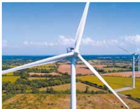
Plus les pales de l'éolienne sont longues, plus elle augmente sa capacité de production.
